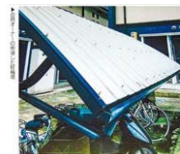
新潟県の駐輪場40カ所耐荷重不足の疑い
